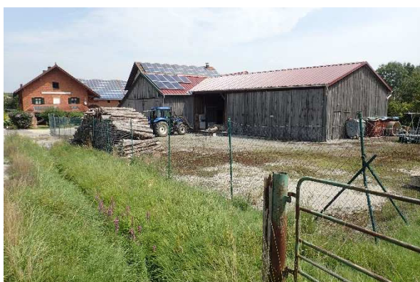
Blick von der Straße nach Norden über den Straßengraben auf die Hofstelle (links) und die Unterstellhalle (rechts)
